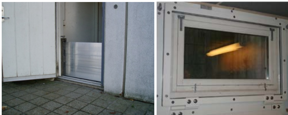
Figur 4.3.2-1 Isætning af skot ved døråbninger og vinduespartier. ( www.stormflodssikring.dk )
