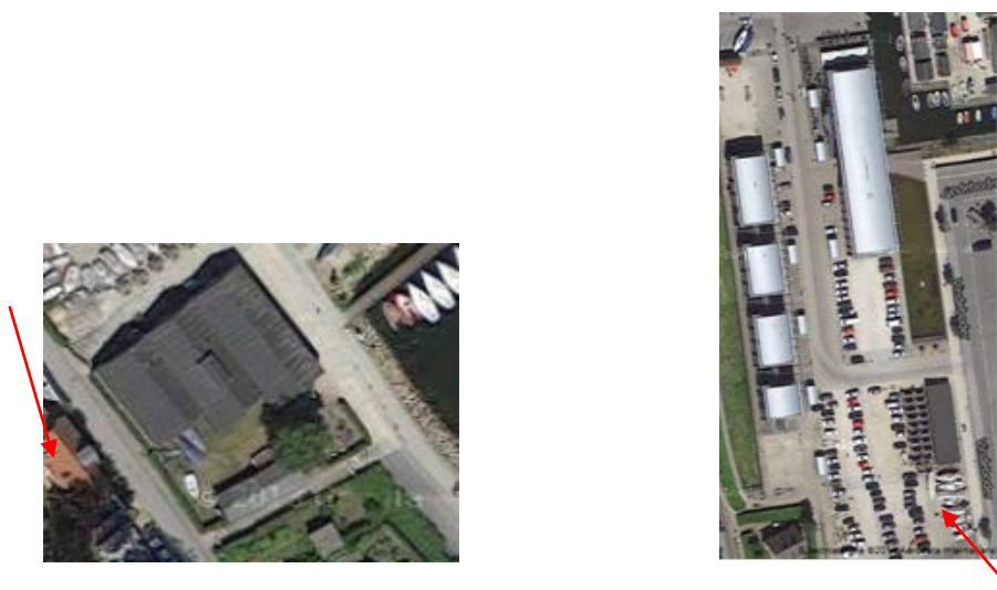
Figur 4.1.1-4: Start og afslutning af mobil søjle-bjælke løsning
