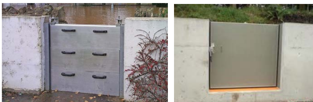
Figur 4.1.1-3: Eksempel på skot til haveindgangene i havnepromenademuren.
