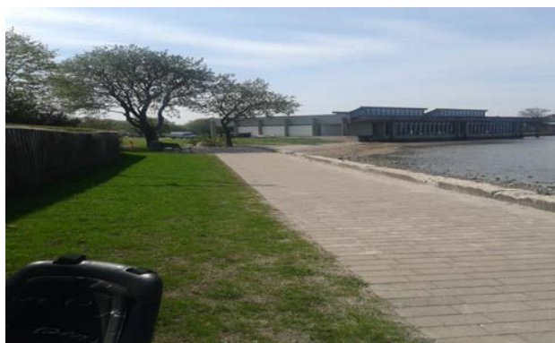
Figur 4.3-2: Eksisterende betonmur i den østlige del af Roskilde Fjord
